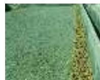
Penyusunan gravel filter di HGF
